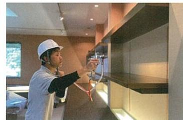
透明性被膜を形成し、基材の風合いを損なわず施工が可能です。また、完全水系で攪拌の手間もなく後処理も簡便で作業性に優れています。
